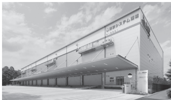
「MCUD鶴ヶ島」の外観
