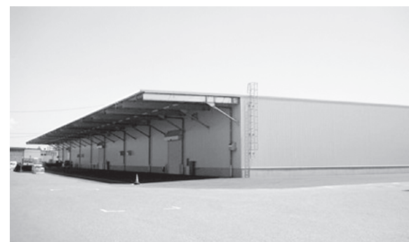
新倉庫の外観
