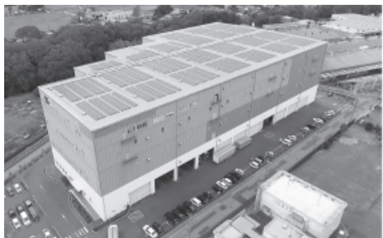
センターが入居するLandport春日部
