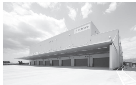
愛西配送センターの外観（画像提供：東洋建設株式会社）
