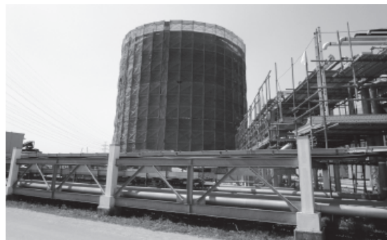
鹿島タンクターミナルは大型指定可燃物タンクを建設
