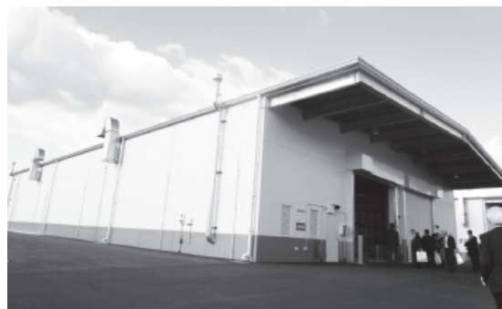
兵機海運の兵庫埠頭物流センターの危険物倉庫
