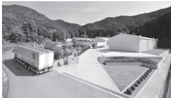
石見サービスは輸送との一体サービスを提供
