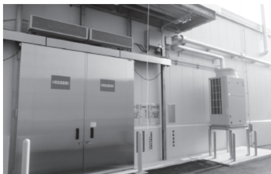
鶴丸海運の定温危険物倉庫
