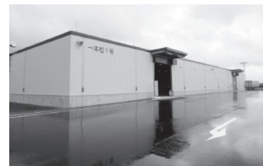
小樽倉庫初となった危険物倉庫
