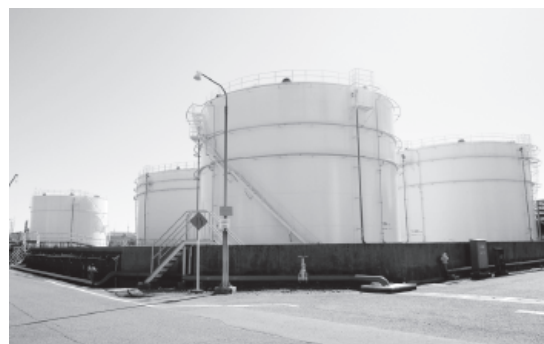
東京油槽が改造工事を終えた大型ケミカルタンク
