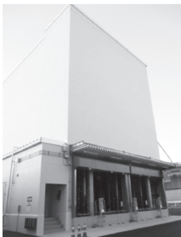
丸一海運の危険物自動立体倉庫
