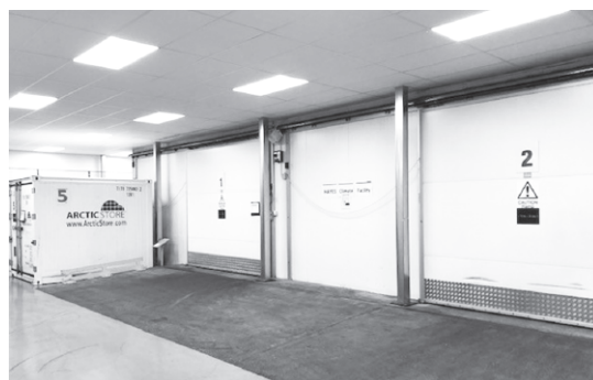
温度管理倉庫の室内
