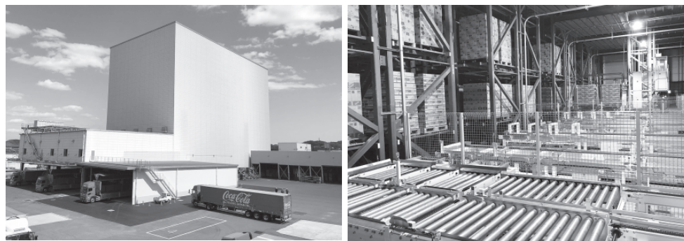
再稼働した本郷自動倉庫の外観（左）と内部
