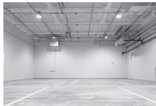
第2期工事の定温対応の危険物倉庫
