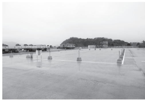
屋外危険物貯蔵所
